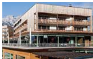
Travel Charme Bergresort Werfenweng: Entsprechend der natürlichen Umgebung dominiert bei der Fassade der Werkstoff Holz.
