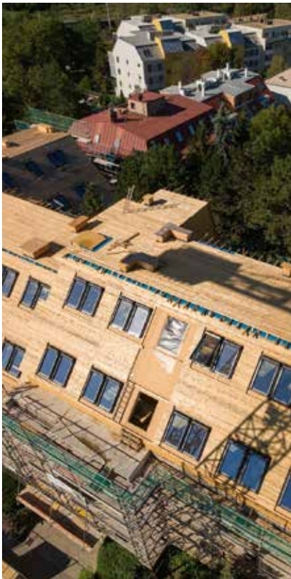
Für die BUWOG revitalisiert DURST-BAU im 14. Bezirk ein Wohngebäude aus der 70ern.
