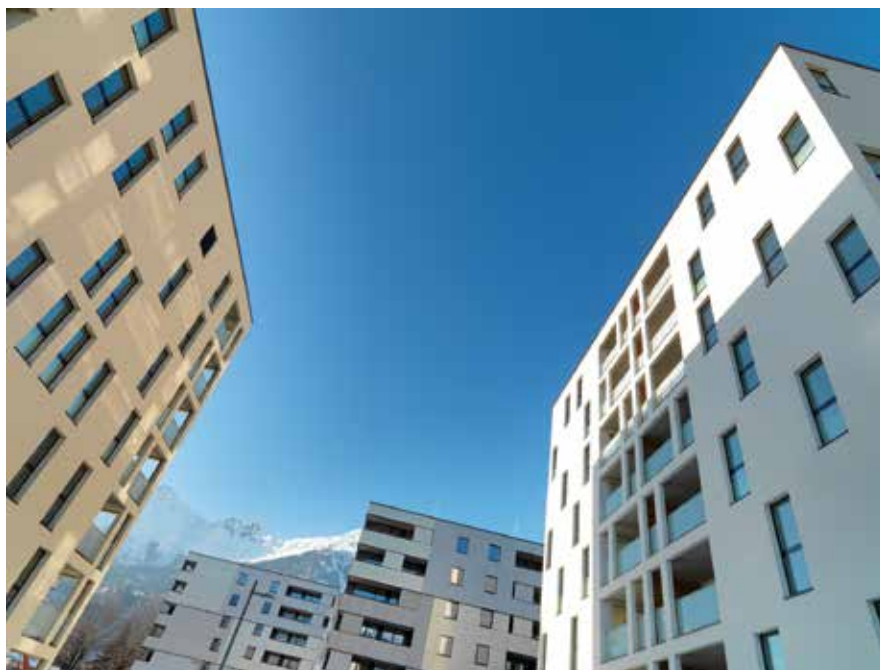
Die Passivhausfenster im Wohnbau »Olympisches Dorf 3« sind aus Aluminium.
