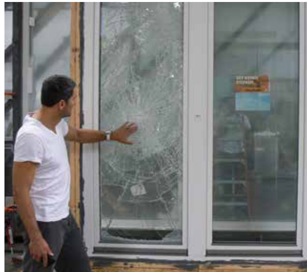
Bei der Hurrikan-Prüfung in Florida wurden die Gaulhofer-Genster enormen Belastungen ausgesetzt.
