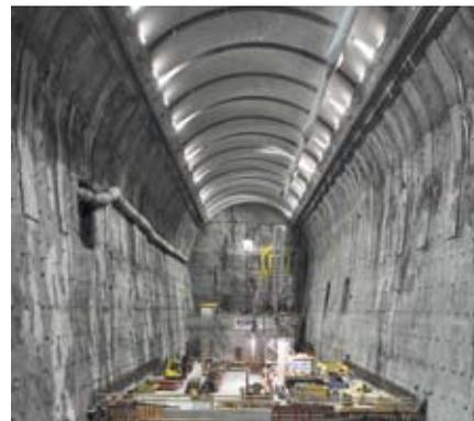
Am Fuße des Limmernsees entsteht die riesige unterirdische Maschinenzentrale für die Kraftwerksturbinen. Zum Einsatz für die Wände kommt hier die Mammut 350 von Meva.
