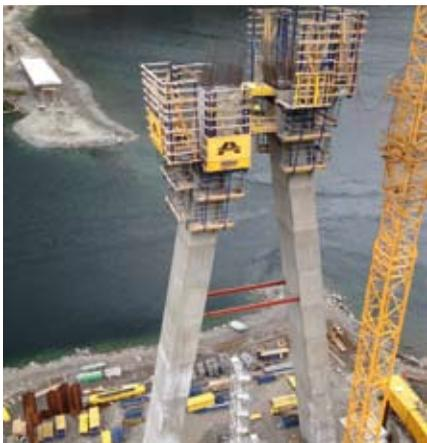
In Nordnorwegen entsteht mit Doka-Know-how eine Brücke über den Kåfjord. Beim Bau des 72,5 m hohen Pylons kommen neun SKE-Kletterautomaten zum Einsatz.
