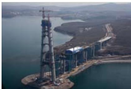
Beim Bau der Ruski-Brücke musste das Harsco Selbstkletterschalsystem SCF widrigsten klimatischen Bedingungen standhalten.
