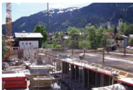
Die Geschößdecken des neuen Raiffeisen Hauses in Kitzbühel werden mit dem Stahlrahmentisch Topmax von Harsco geschalt.
