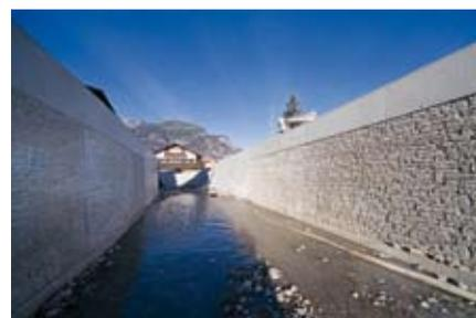
Die betonierten Seitenwände sind mithilfe von NOEplast Strukturmatrizen einem Natursteinmauerwerk nachempfunden.
