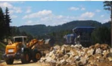
Bei der Errichtung des 1,5 Kilometer langen Bauloses 4.2 werden von Hochtief 400.000 Kubikmeter Felsabbruch aufbereitet und als Schüttgut oder in der Betonverarbeitung verwertet.
