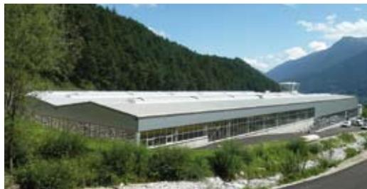
800 Tonnen Stahl wurden von der Unger Steel Group für die 7.000 Quadratmeter große, dreischiffige Industriehalle verbaut.
