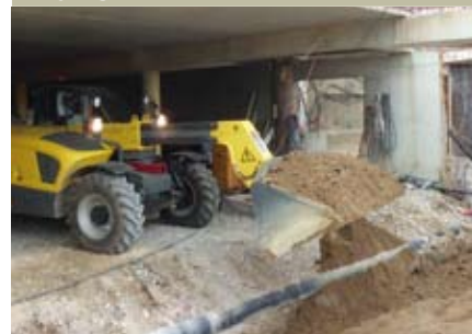
Mithilfe eines Kramer Teleskops 2506 wird ein 4-Sterne-Wellness-Hotel im Schwarzwald um eine zusätzliche Tiefgarage erweitert.
