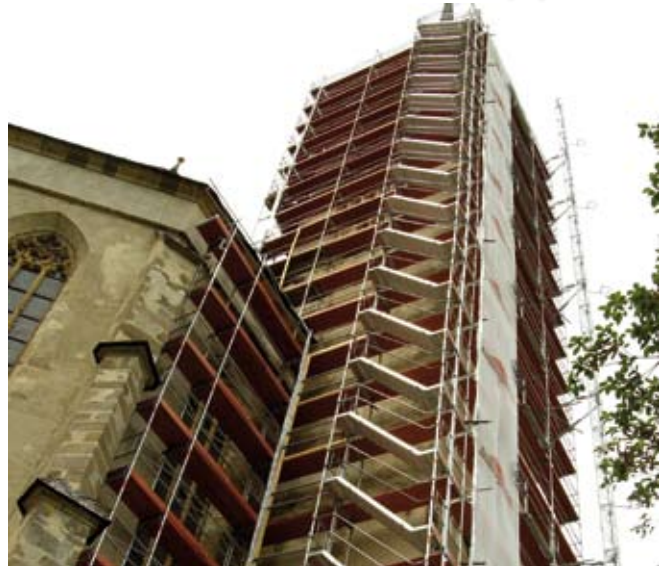
Seit vielen Jahren zählt Ringer zu den Vorreitern bei Gerüst-Außenaufstiegen (im Bild: Kirche in Tamsweg).
