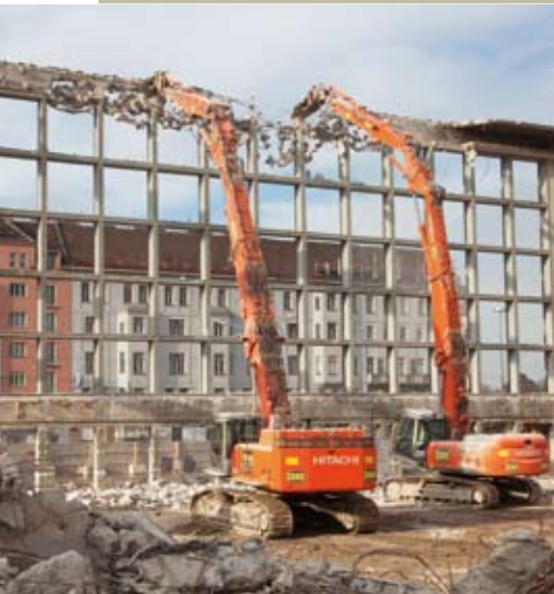
Zwei Hitachi-Abbruchbagger legten den Südbahnhof in Schutt und Asche.
