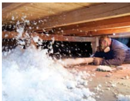
Die neue Blaswolle: schnell, sauber und nachhaltig gedämmt.
