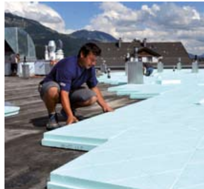
Der Klassiker am Umkehrdach aus dem Hause Steinbacher: steinodur UKD® –Top-Wärmedämmung und noch mehr Energie- und Kostenersparnis.
