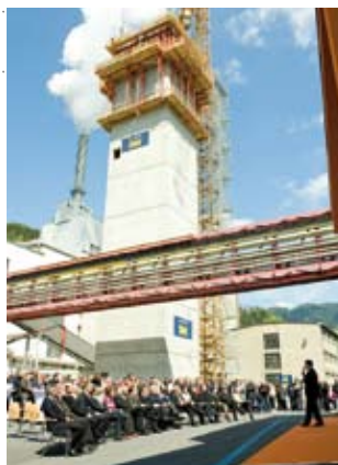
Mit Vertretern aus Politik und Industrie fand am 17. April die Spatenstichfeier für den neuen Laugenverbrennungskessel statt.
