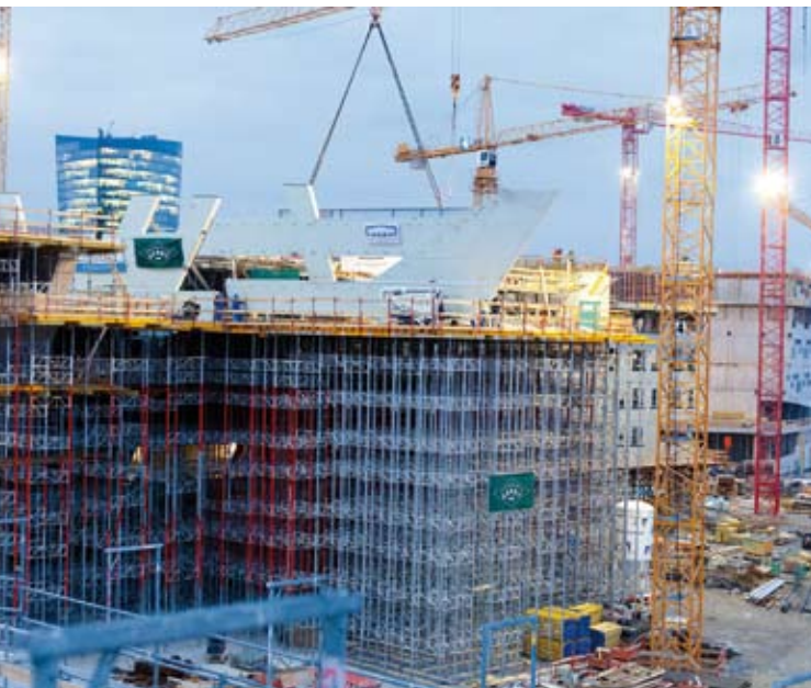
Schwebende Stahlkonstruktion der Unger Steel Group für das LLC des WU Campus.
