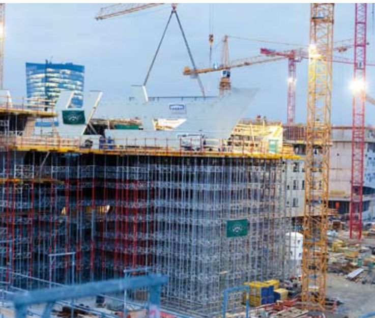
Schwebende Stahlkonstruktion der Unger Steel Group für das LLC des WU Campus.
