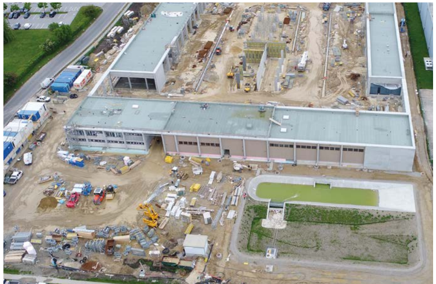
Die neue Autobahnmeisterei Bruck an der Leitha wurde von Asfinag und Leyrer + Graf als BIM-Pilotprojekt umgesetzt, mit dem Ziel, BIM aus der Planungsphase auf die Baustelle zu holen.
