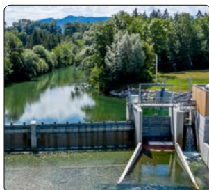
Neu errichtetes Wasserkraftwerk Rittmühle an der Alm im Traunviertel in Oberösterreich.
