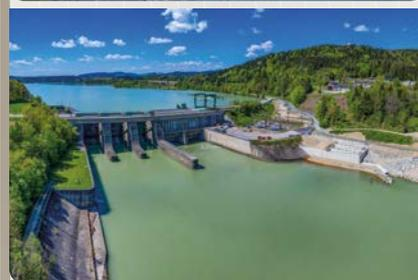
Schlitzpass der Fischwanderhilfe beim Kraftwerk Edling an der Drau aus der Vogelperspektive.
