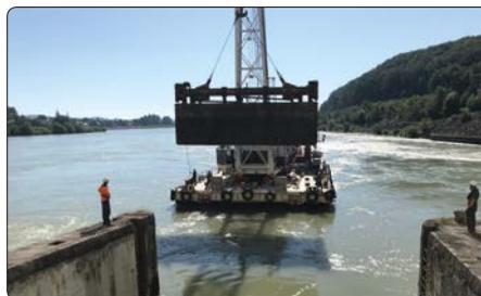
Arbeiten am Wasser: Abdämmen der Maschine 2 beim Donaukraftwerk Ybbs-Persenbeug.
