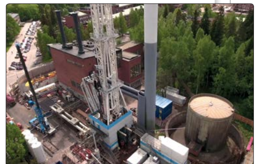
Blick über das Forschungsprojekt St1 Deep Heat Oy in Helsinki.
