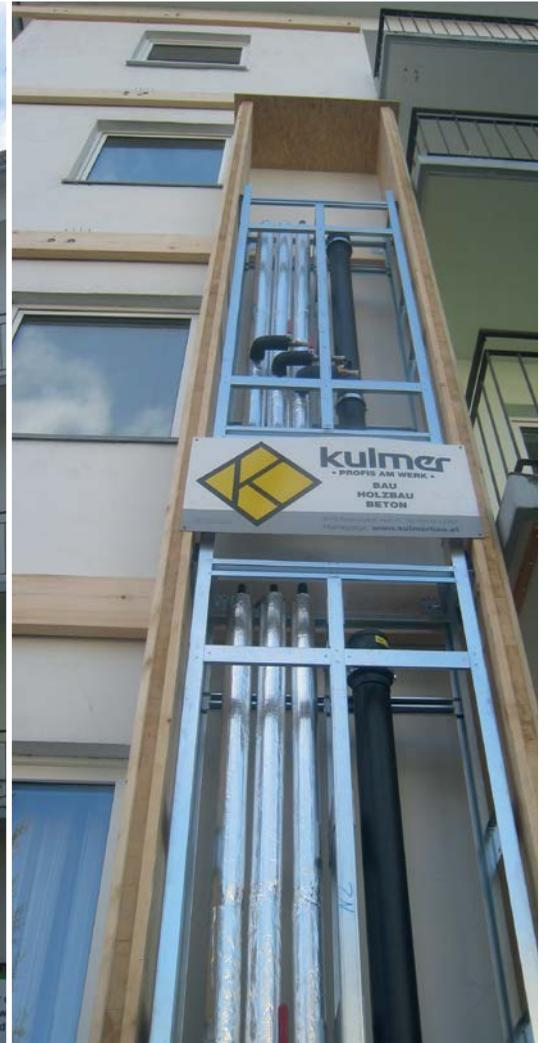
Vorgefertigte Fassadensysteme mit integrierter Haustechnik werden erst an wenigen Demoprojekten angewandt.
