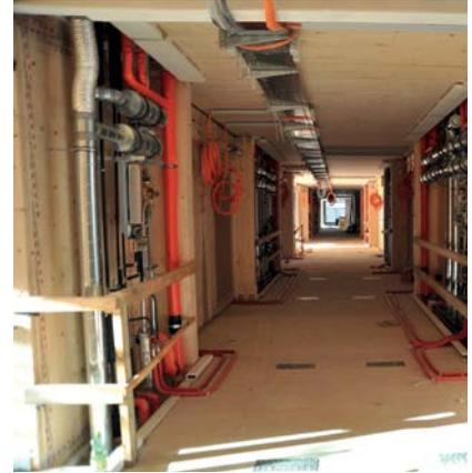
sps-architekten arbeitet mit Leitungen an der innenliegenden Fassade, dem Gang. Interessant ist das vor allem als Lösung bei historischen Fassaden.
