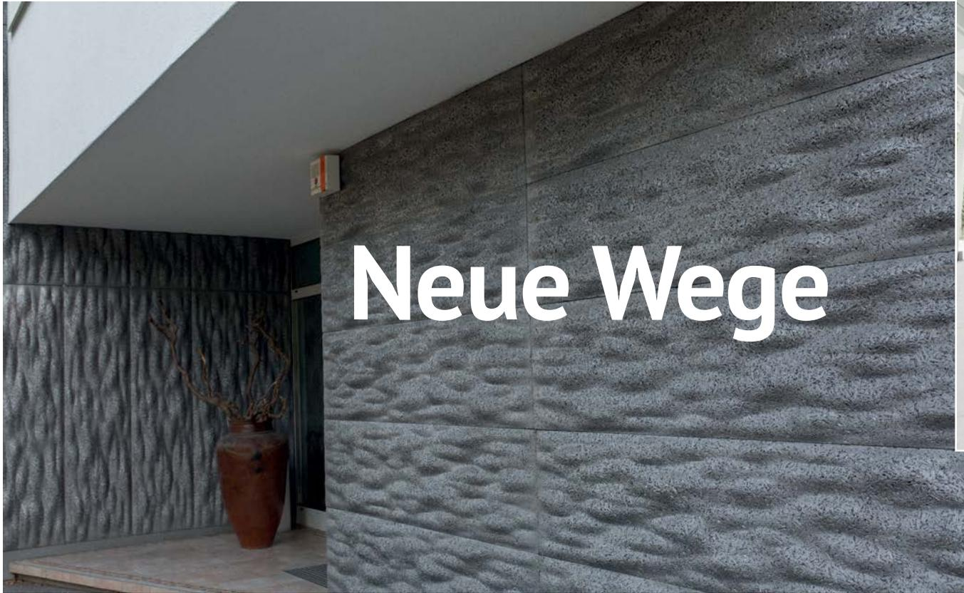
Absorbierende Fassaden sind eine Lösung für Schallreduktion im städtischen Hochbau. (Im Bild: die Velox Hybrid-Fassade)
