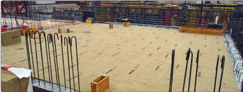
Decrock zeichnet sich durch eine einfache Verarbeitung aus: Die Platten werden in die Schalung eingelegt, zusätzliche Befestigungsmittel sind nicht erforderlich.
