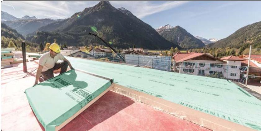
Aufgrund seiner hohen Dämmleistung und einlagigen Verlegung eignet sich Polyurethan (PU) besonders für Bauteile, bei denen schlanke Aufbauten von Nutzen sind, z.B. in der Steildachdämmung.
