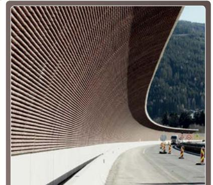
Effektiv gegen Lärm: Schutzkonstruktionen aus Beton.
