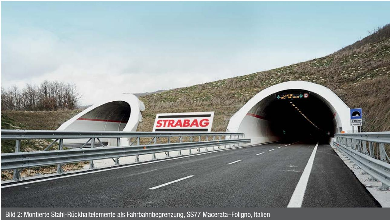
Bild 2: Montierte Stahl-Rückhaltelemente als Fahrbahnbegrenzung, SS77 Macerata–Foligno, Italien
