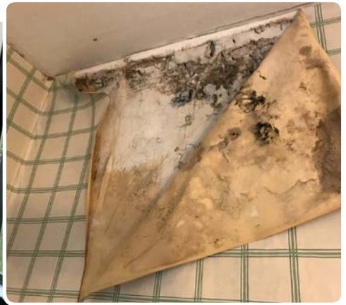
Schimmelbefall entsteht bei erhöhter Feuchtigkeit nicht nur an Stellen, die sofort ins Auge fallen, sondern insbesondere verdeckt an schlecht belüfteten Stellen wie etwa hinter Fußleisten, Schränken, Tapeten oder Verkleidungen.
