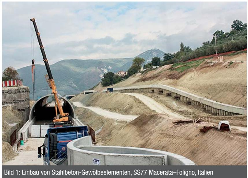
Bild 1: Einbau von Stahlbeton-Gewölbeelementen, SS77 Macerata–Foligno, Italien
