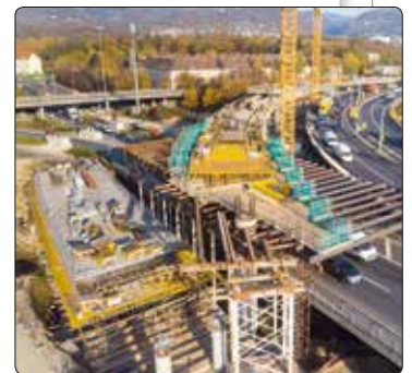
Der Ausbau der A 7 Mühlkreis Autobahn schreitet sichtbar und plangemäß voran.
