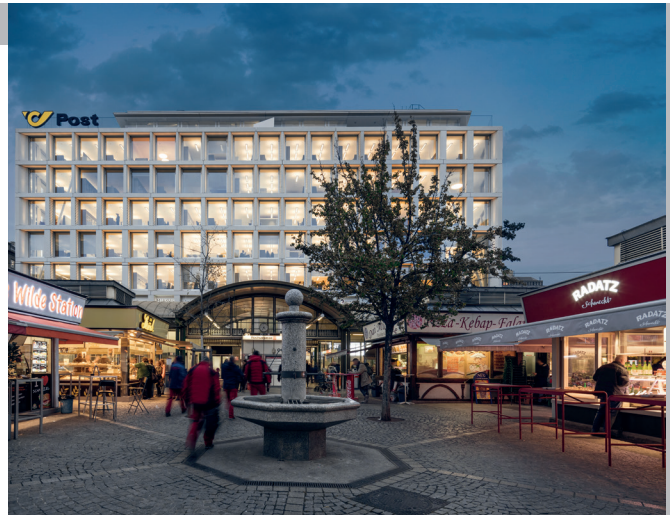
Der Prüfstand des AIT wurde am Neubau der Unternehmenszentrale der Post AG am Wiener Rochusmarkt erfolgreich angewendet.
