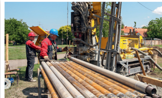
In Zürich wird ein Erdwärmesondenfeld direkt unter dem Quartierzentrum errichtet – mitten in der Stadt.
