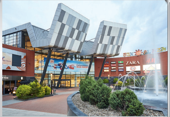
Die S Immo konzentriert sich verstärkt auf Projektentwicklungen und Investitionen in Bestandsimmobilien. Eben wurde der Umbau des Sun Plaza-Einkaufszentrum in Bukarest eröffnet.
