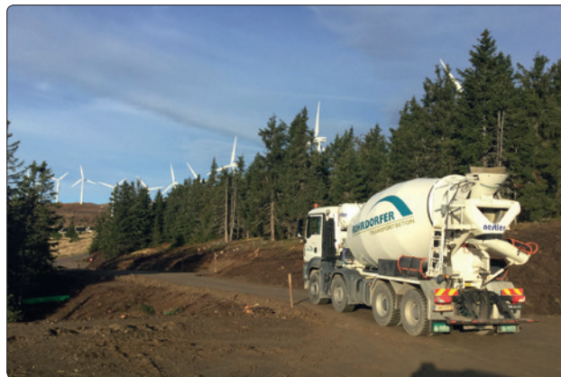
Rohrdorfer lieferte täglich zwischen 500 und 600 m 3 Beton zu dem auf einer Seehöhe von 1.900 Metern gelegenen Tauernwindpark.
