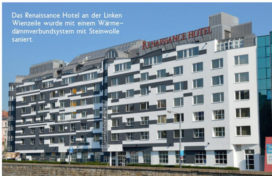
Das Renaissance Hotel an der Linken Wienzeile wurde mit einem Wärme-dämmverbundsystem mit Steinwolle saniert.
