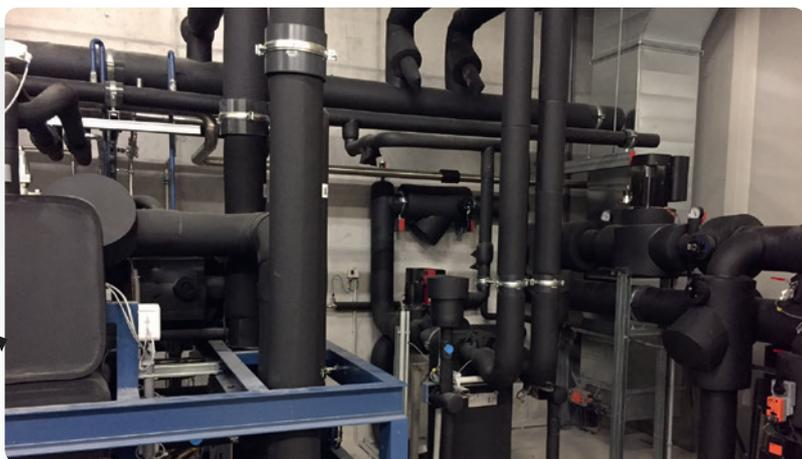
In der Fleischerbranche sind drehzahlregelte Kühlmaschinen in Betrieb, deren Abwärme für die Bereitstellung von Warmwasser genutzt wird.
