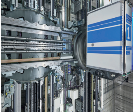
Der Multi von ThyssenKrupp lässt mehrere Kabinen pro Schacht unabhängig voneinander zirkulieren.
