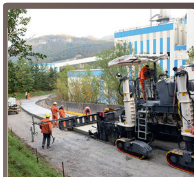
Für den Einsatz im niederrangigen Straßennetz müssen die Betonfertiger mit wenig Platz auskommen. Im Bild: Teststrecke beim Zementwerk Leube.
