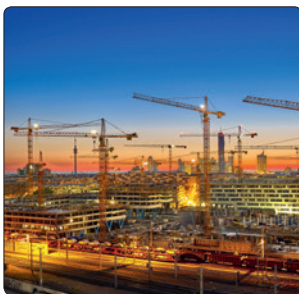
Liebherr-Turmdrehkran-Flotte am Austria Campus in Wien.
