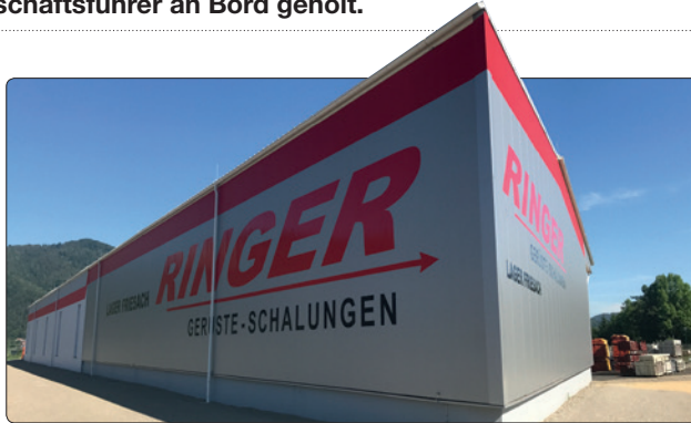
In Gratkorn-Friesach errichtet Ringer ein 10.000 m 2 großes Betriebsareal mit 2.500 m 2 Lager- und Bürofläche.
