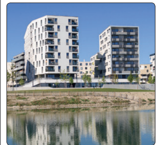
Die Seestadt bekommt Zuwachs. Neben Wohnungen wird auch die nötige Infrastruktur ausgebaut.
