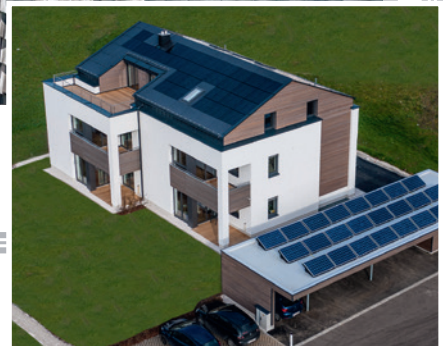
Durch die starke Neigung eignen sich die Dachflächen des Steildaches besonders gut zur Integration von Photovoltaik- oder Solarpaneelen. Im Bild: Eternit Integral 2 Haus der Zukunft in Seewalchen.
