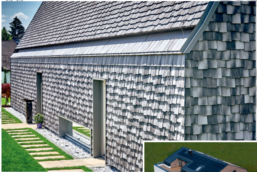
Eine besondere Optik bieten Dachziegel in der Fassade.
