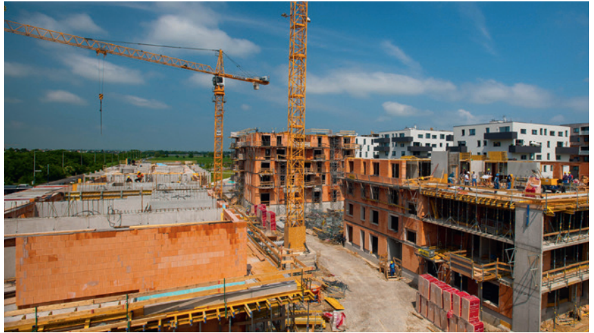
Der anhaltende Zuzug von Menschen in die Städte ist für Franz Kolnerberger, Geschäftsführer Wienerberger Ziegelindustrie, die Garantie, dass Bauprojekte auch in Zukunft nicht ausgehen.
