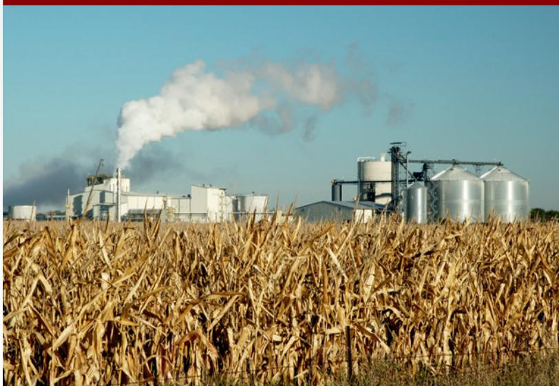
**Mit Bioethanol CO<sub>2</sub> sparen?** Eine industrielle Anlage in Illinois verbindet Biospritgewinnung mit Kohlendioxid-Endlagerung unter Tage.
