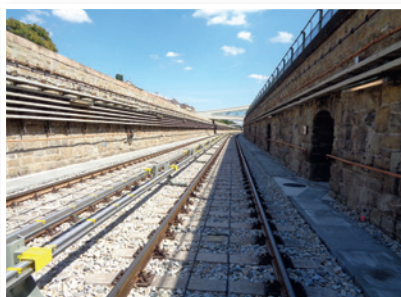
Fertig sanierter U4-Teilabschnitt zwischen Stationen Unter Sankt Veit und Braunschweigasse.
