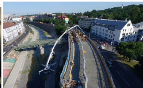
Herstellung Dichtbetonplatten oberhalb Gewölbe im Streckenbereich zwischen Stationen Hütteldorf und Ober Sankt Veit.
