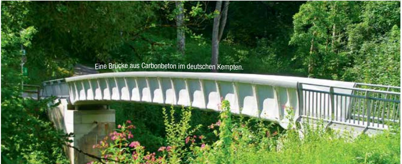
Eine Brücke aus Carbonbeton im deutschen Kempten.
