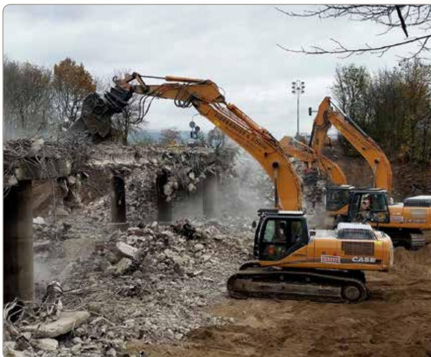
Schicht Sand. Nachdem die Fahrbahn entsprechend geschützt war, konnten die Raupenbagger ungestört mit ihrem geplanten Zerstörungswerk beginnen. Nach Abschluss der eigentlichen Abrissarbeiten
