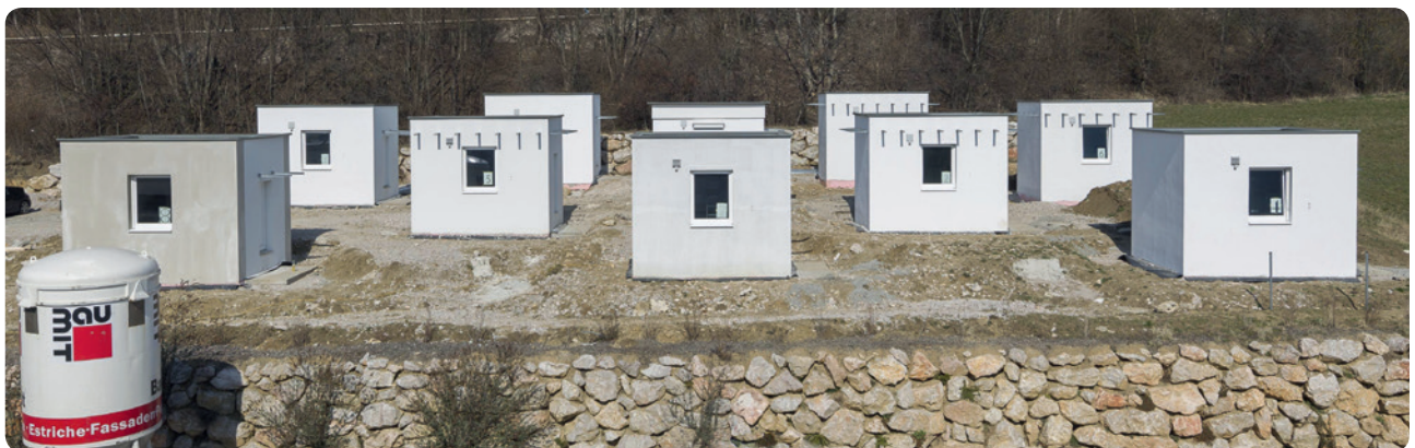
Die zehn Häuser des Forschungsparks in Wopfung liefern wertvolle Erkenntnisse über die Auswirkungen eingesetzter Baumaterialien.
