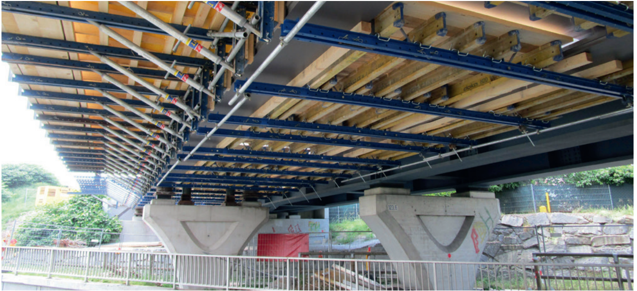
Der modulare Aufbau der ParaTop Brückenschalung erlaubt die vollflexible Anpassung an verschiedenste Kragarmquerschnitte.
