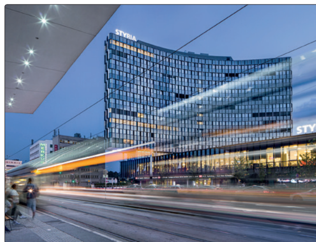
Mit einem Schindler 5500 geht es in die Skylobby im Dachgeschoß des Styria Media Centers.
