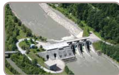
Das Kraftwerk Fritzbach im Pongau speist in der ersten Jahreshälfte 2015 erstmals Ökostrom ins öffentliche Netz.
