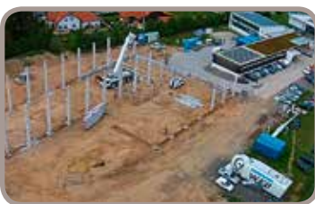
Blick aus der Drohnenperspektive: Der Zubau auf dem W.E.B-Firmenareal schreitet zügig voran
