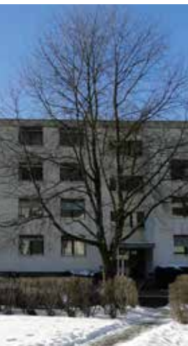
Der spezifische Heizwärmebedarf des VOGEWOSI-Mehrfamilienhauses in Bludenz-Kreuz, errichtet 1978, lag vor der Sanierung bei 94 kWh/m 2 a, nach der Sanierung bei 20 kWh/m 2 a.
