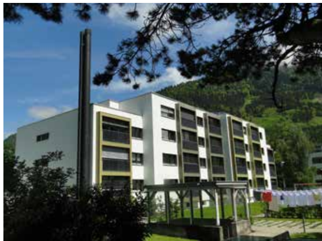
Der spezifische Heizwärmebedarf des VOGEWOSI-Mehrfamilienhauses in Bludenz-Kreuz, errichtet 1978, lag vor der Sanierung bei 94 kWh/m 2 a, nach der Sanierung bei 20 kWh/m 2 a.
