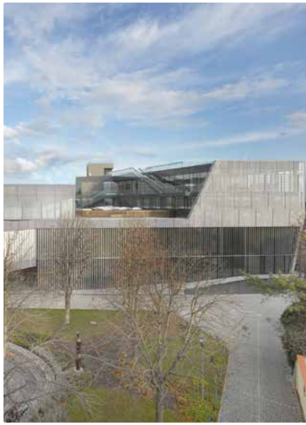
Kultur Kongress Zentrum Eisenstadt: überzeugend sowohl städtebaulich als auch in seiner Verschränkung von Bestand und Neubau. Der das Gebäude umhüllende Metallscreen schafft eine Einheit.
