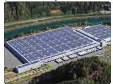
Am Dach der Hofer-Zweigniederlassung Weißenbach wird Strom erzeugt.
