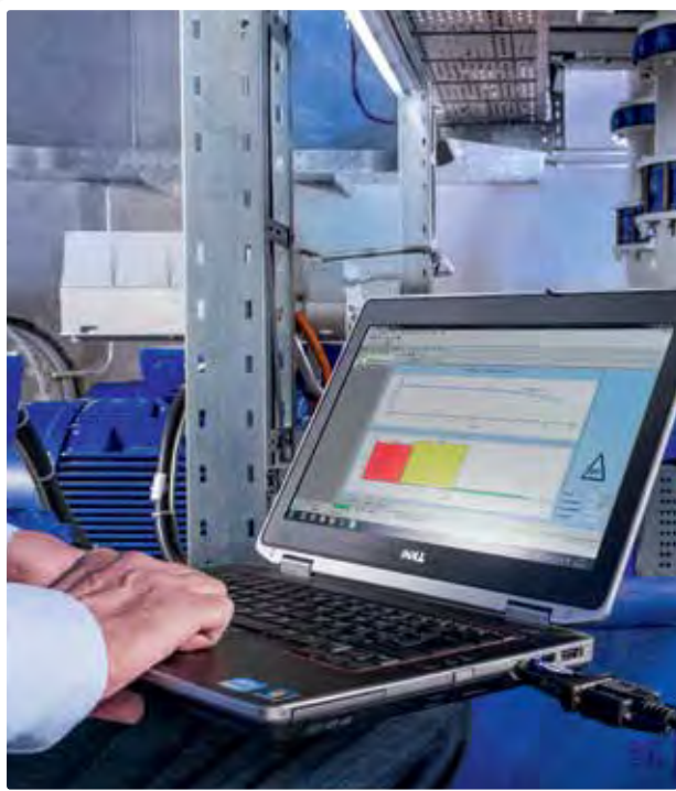
Durchführung einer PumpMeter-Analyse an einer einstufigen Wasserpumpe der Baureihe Etanorm.
