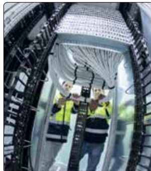
Linz AG Telekom bietet neues Rechenzentrum für Unternehmen (nicht nur) in Oberösterreich.
