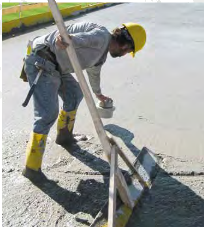
Mit Concremote Betonmonitoring können die Anwender auf Basis von Messwerten zur Betonfestigkeit den Bauprozess optimieren.
