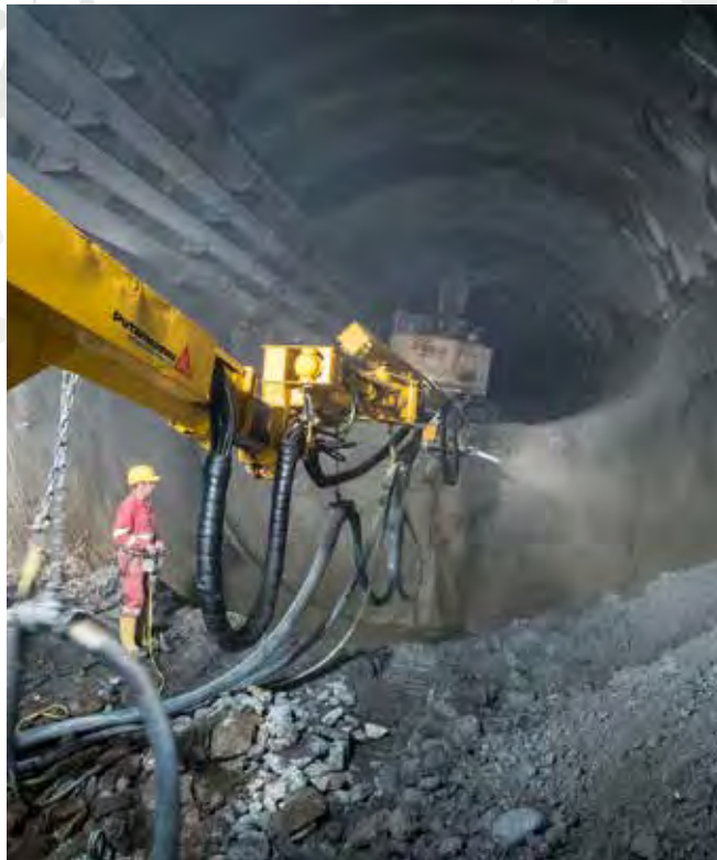
Cemex Österreich liefert 540.000 m 3 Beton und Spezialbaustoffe für das Projekt Koralmtunnel.
