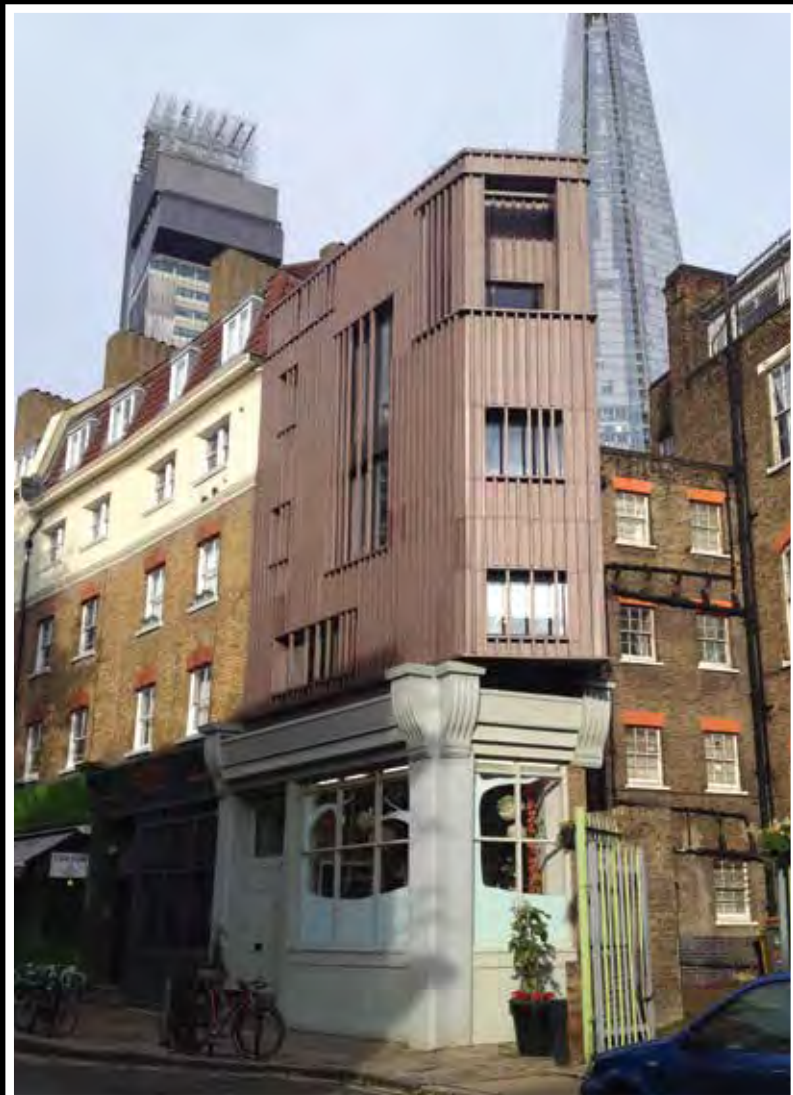
Der Außeneindruck des Alex Monroe Designstudios in London ist durch die Zinkverkleidung der Fassade metallisch hart. Im Inneren offenbart das Gebäude eine Konstruktion aus Brettsperholz.
