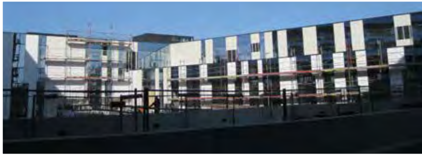
Die Eröffnung des neuen Pflegewohnhauses Donaustadt ist für November 2014 geplant.
