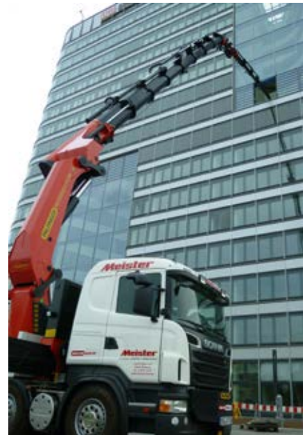
Der neue Langarmkran Palfinger PK 200002 L SH transportierte zielsicher etliche ausgewachsene Bäume auf 30 Meter Höhe in die neu angelegten Wintergärten eines Frankfurter Bürokomplexes.
