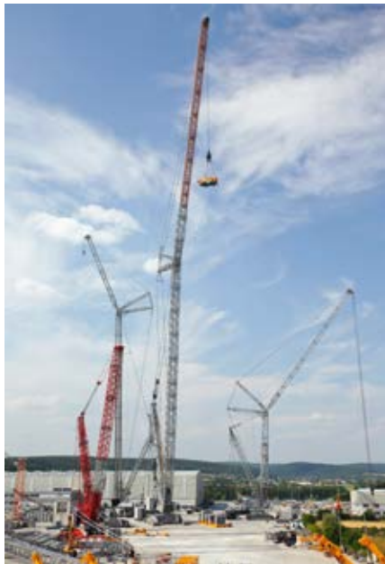
Der weltweit höchste Raupenkran kommt von Liebherr und erreicht eine Höhe von 248 Metern.
