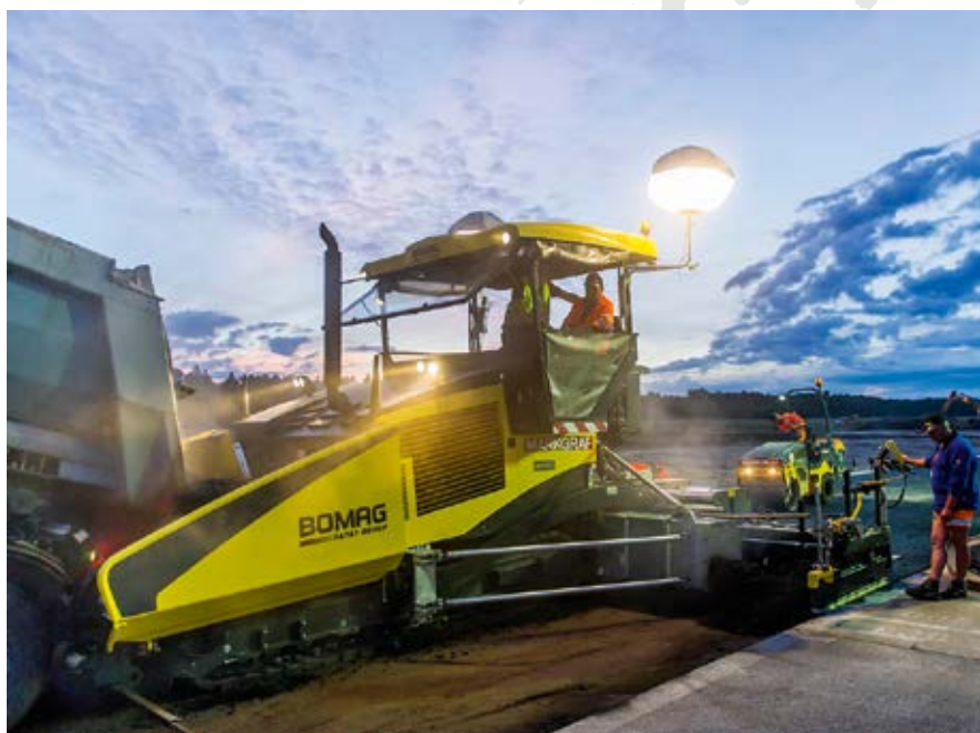
Die Nachtbaustelle am frühen Morgen: Der Bautrupps der W. Markgraf GmbH & Co KG beim Einbau der 14 cm dicken und 7,50 m breiten Asphalttragschicht.
