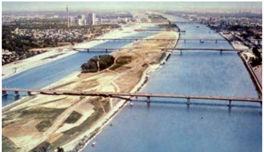
Der Bau der Donauinsel dauerte von 1972 bis 1988 und verschlang mehr als drei Milliarden Schilling. Dafür bleibt Wien jetzt auch bei einem Jahrhunderthochwasser trocken.
