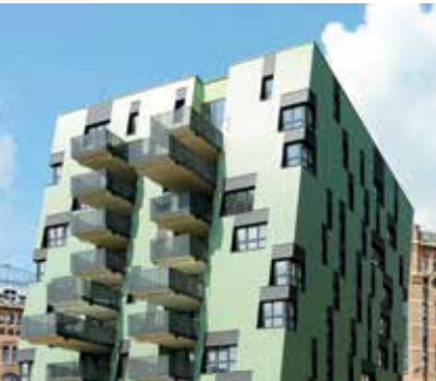
Vorgehängte, hinterlüftete Fassaden rücken immer stärker in den Fokus.
