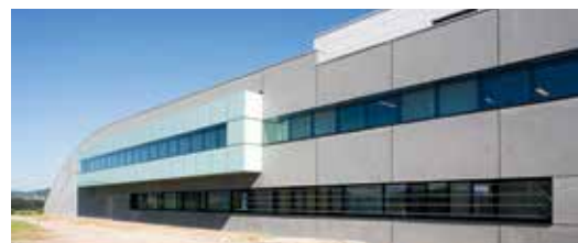
Beständigkeit mit Sichtbeton.
