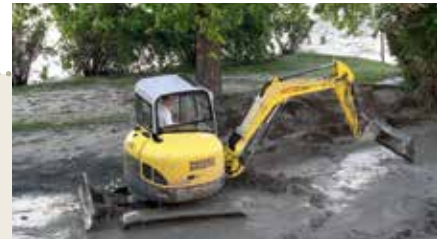
Wacker Neuson Bagger im Einsatz gegen die Schlammmassen.
