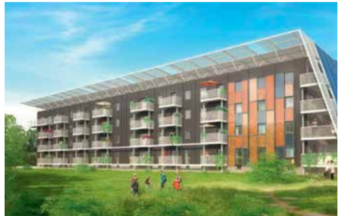
In Kapfenberg wird ein echtes Plus-Energiehaus errichtet.
