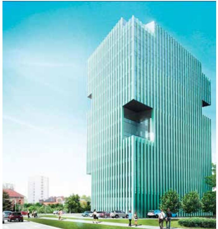
Der Alma-Tower soll dank seiner auffälliger Fassade zu einer echten Landmarke in Krakau werden.
