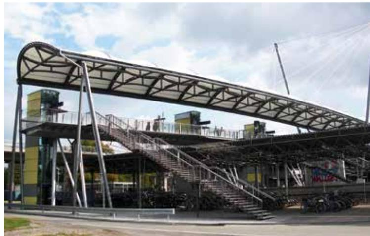
Zeman realisierte das 85 Tonnen schwere Stahldach im deutschen Wiesloch. Besonders spektakulär gestaltete sich die Einhebeaktion der Konstruktion.
