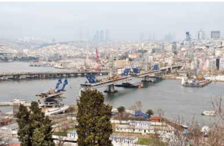
In Istanbul realisiert Waagner Biro die 120 Meter lange Golden Horn Swing Bridge. Die Drehbrücke ist mit elektrohydraulischem Antrieb ausgestattet und dreht sich mit bis zu 90 Grad um das Zentrum
