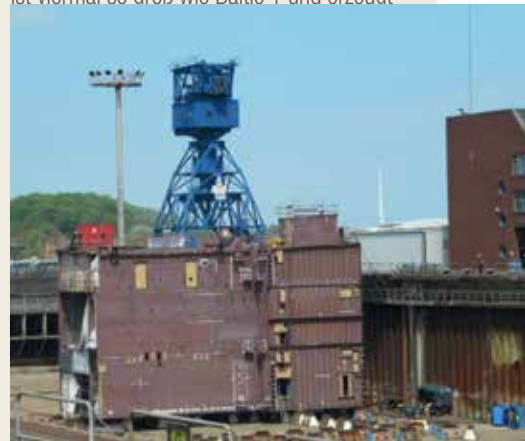
Die Endmontage der Umspannplattform für den Windpark Baltic 2 im Kieler Trockendock. Alstom liefert die Elektrotechnik.
