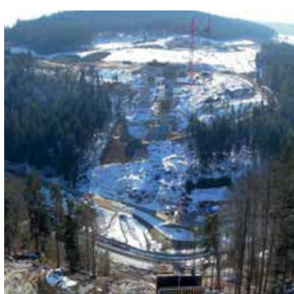
Die S10 ist eines der aktuellen Vorzeigeprojekte von Hochtief Construction Austria.
