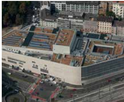
Eines der modernsten Musiktheater in Europa wurde von Strabag in Linz errichtet.
