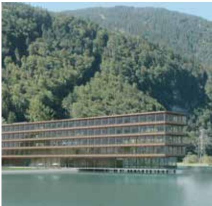
Für die Illwerke AG errichtet Rhomberg das größte Green Building Vorarlbergs.
