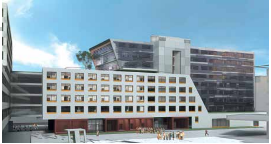
In Wien Donaustadt errichtet Swietelsky den gemischt genutzten Gebäudekomplex Star 22.
