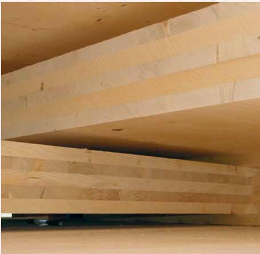
Der typische Aufbau von Brettsperrholz erfolgt mit zueinander im rechten Winkel orientierten Brettlagen, die durch Verleimung starr miteinander verbunden werden.
