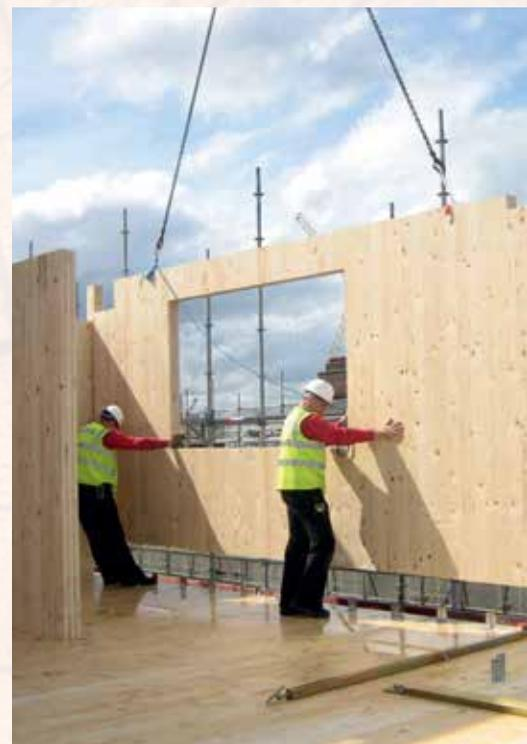
»Die plangetreue Umsetzung der Bauteile verlangt eine sehr hohe Genauigkeit vor Ort. Ein Korrigieren und Anpassen auf der Baustelle ist kaum möglich.« (Harald Eder von Hagmüller Architekten über seine Erfahrungen mit Kreuzlagenholz)
