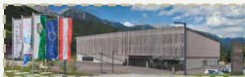
Automatisierungsspezialist KEBA nimmt in Linz »Werk 2« in Betrieb.
