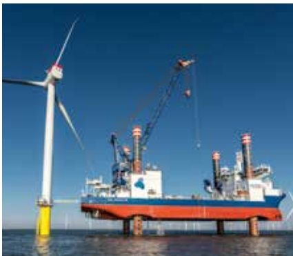
In weniger als 24 Stunden ist im Projekt Gunfleet Sands III eine 6-MW-Windkraftanlage installiert worden. Sie kann bis zu 6.000 europäische Haushalte mit Strom versorgen.
