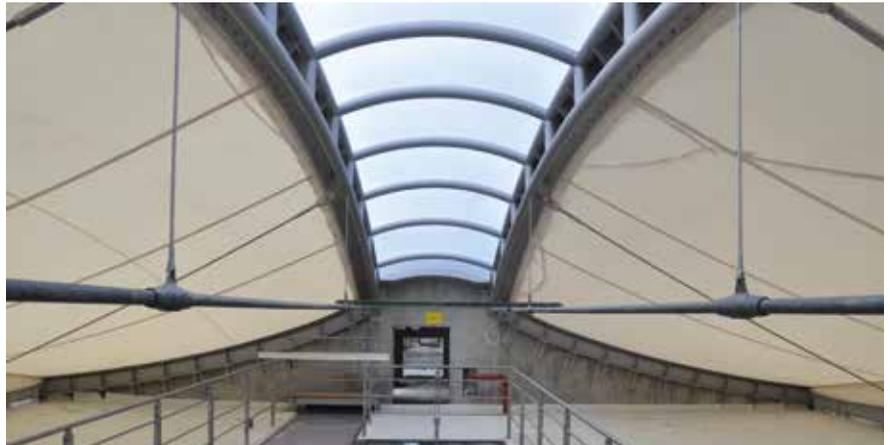
Transparente Dachkonstruktion aus Membranen mit Tageslichtelement.
