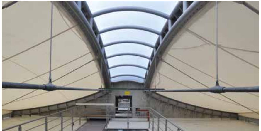
Transparente Dachkonstruktion aus Membranen mit Tageslichtelement.
