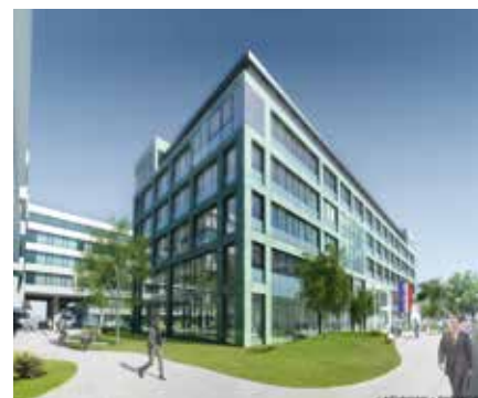
Strauss & Partner realisiert aktuell die fünfte Bauphase von Wiens größtem Office Park Euro Plaza
